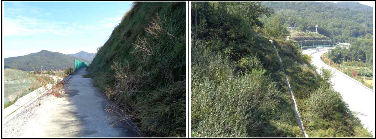
【그림 33.3.3】 배수시설 전경
